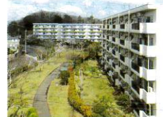
13,500坪の広大な敷地 ※土地建物/自己所有
