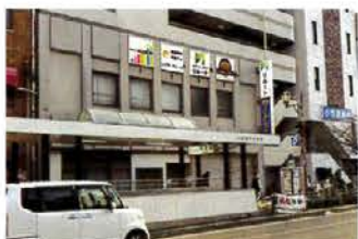
板宿駅南出口(西口)階段を上って すぐの好立地
